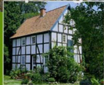
Altes Fachwerk in neuem Glanz
